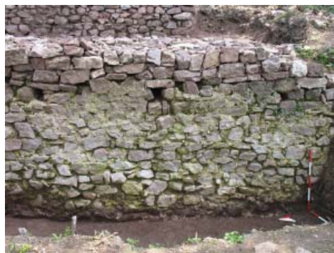
Обр. 46. Крепостната стена, с улеи за оттичане на атмосферните води
